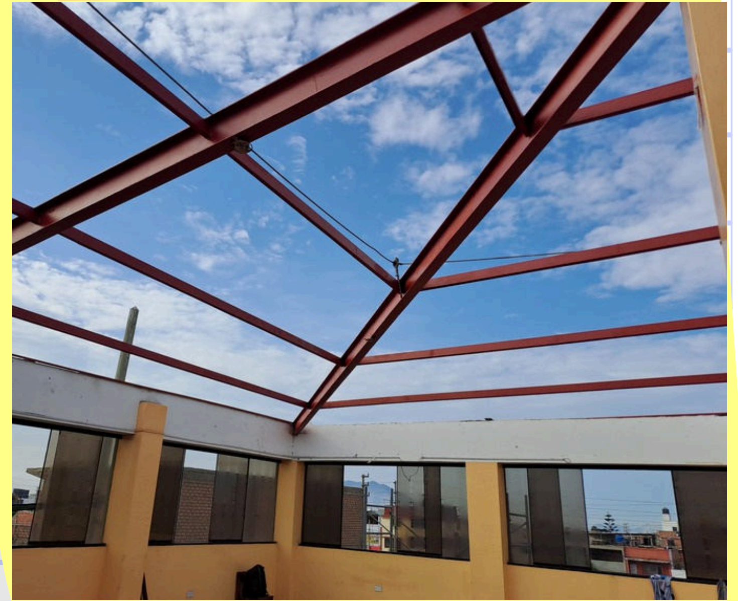
Vigas lijadas y pintadas
